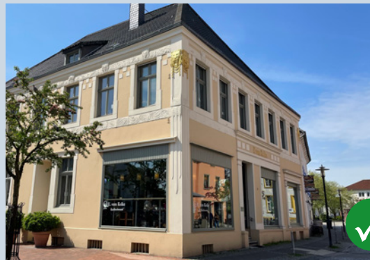
Schaufenster sind in das Gesamtbild der Fassade integriert
