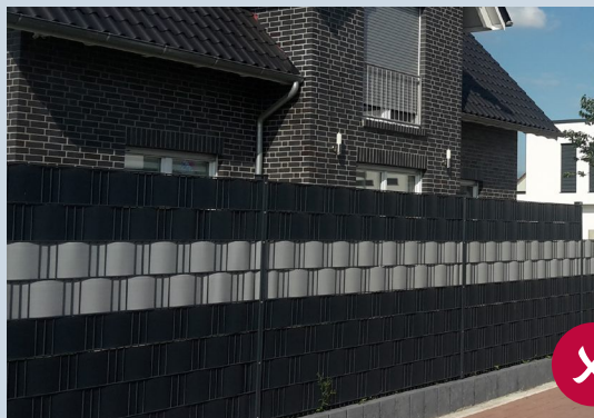
Stabmattenzaun mit Kunststoffeinfriedungen
