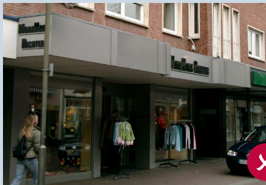
kein gestalterischer Bezug zwischen Erd- und Obergeschossen führt zu getrennter Wirkung
