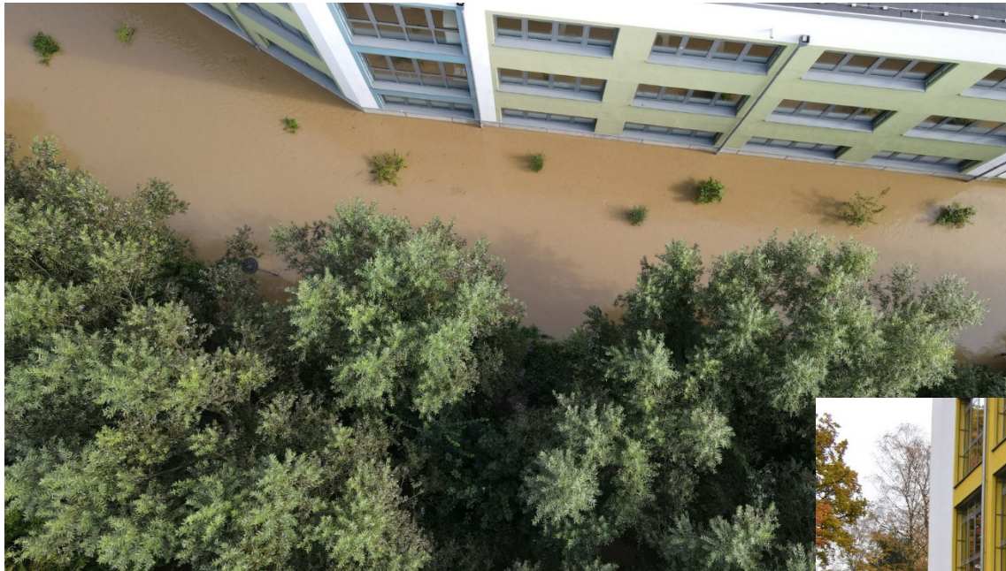
Hochwasserschutz am Neubau des Thomas-Morus-Gymnasiums im HQ-100-Bereich des Axtbaches
