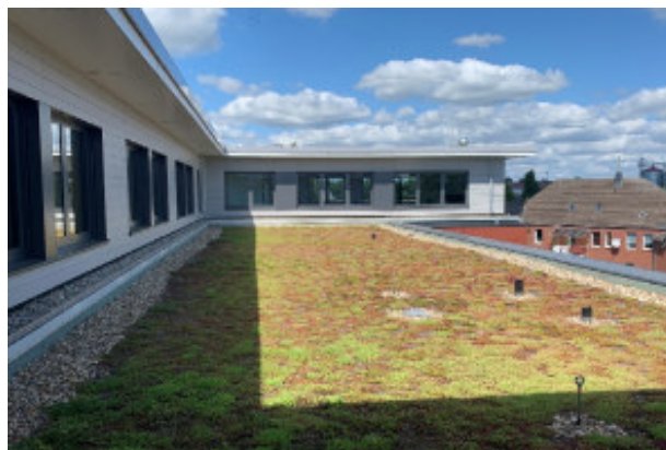
Dachbegrünung auf dem Gebäude der Gesamtschule Oelde (Bild: Stadt Oelde)
